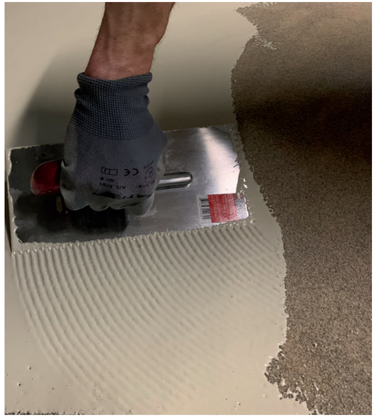
Am Boden: 2-lagige Abdichtungsschicht Schönox EA PUR 2K mischen und einbringen.
