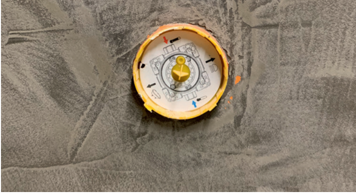
Wände: 2-lagige Abdichtungsschicht Schönox 1K DS Premium mit Zahnpachtel 6 mm.
