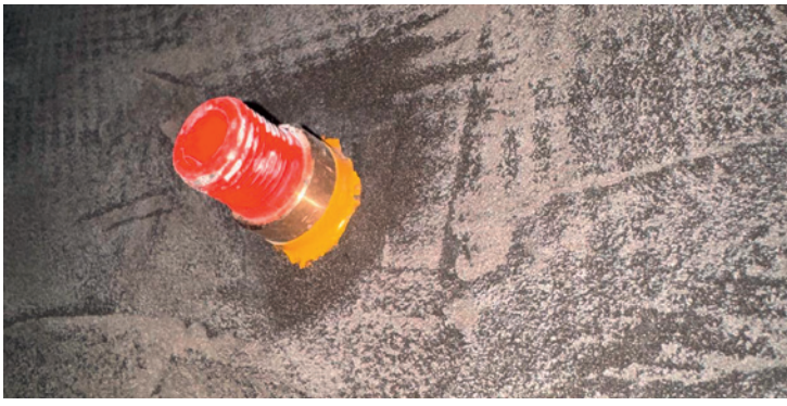
An der Wand: Dehnzonenmanschetten Schönox D15 anbringen.
