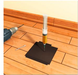
4. Aufsetzen der Spritze und ausfüllen der Hohlstelle mit Kleba Repacol
