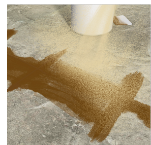
4. Überschüssiges Material glattstreichen und anschliessend mit Klebag Quarzsand 0.2-0.8 mm abstreuen.
